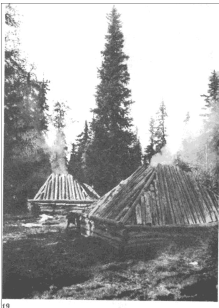
19. Бревенчатые хижины в Геияуре, в лесном районе Маусьяур, Швеция. Они пирамидальной формы на квадратном основании, с осевшим полом, построенным по типичным евроазиатским линиям, объединяющим квадратные или прямоугольные формы с коническими. Ясно видно отверстие в крыше для выхода дыма. Дверь хижины такого же типа, которые делают в торфяных хижинах.
